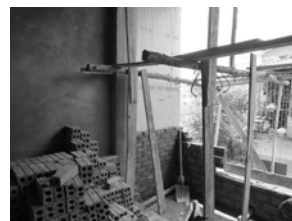
写真2 レンガ壁(奥隣家壁)
