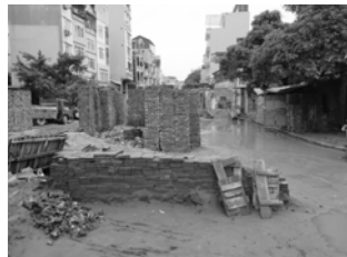
写真9 材料保管場所
